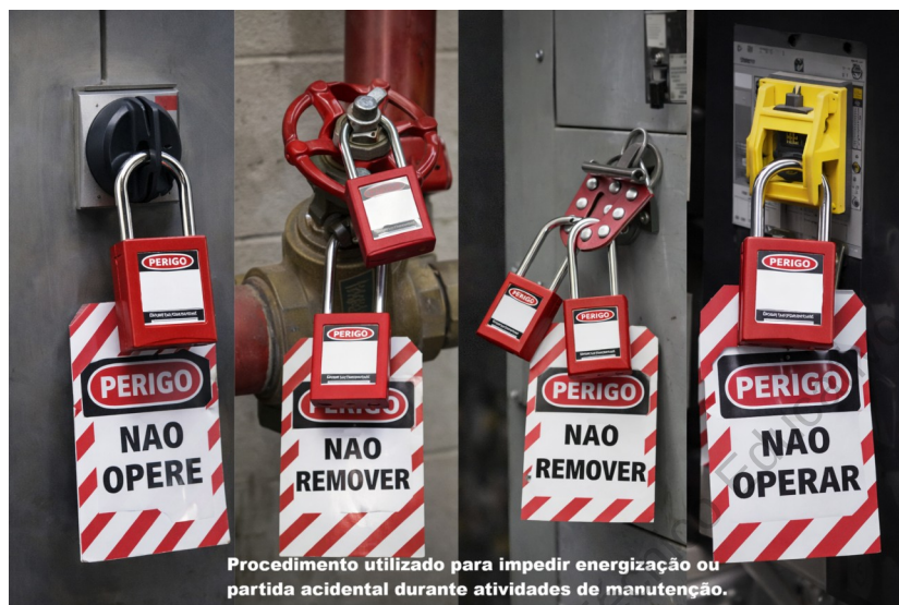
Figura E — Exemplo ilustrativo de aplicação de bloqueio e etiquetagem de fontes de energia
