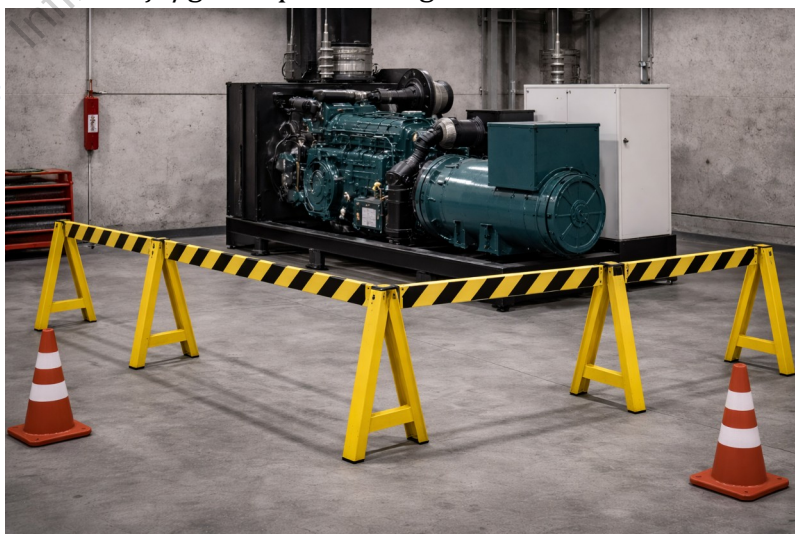
Figura F — Exemplo de EPC: barreiras físicas e sinalização em local de manutenção
